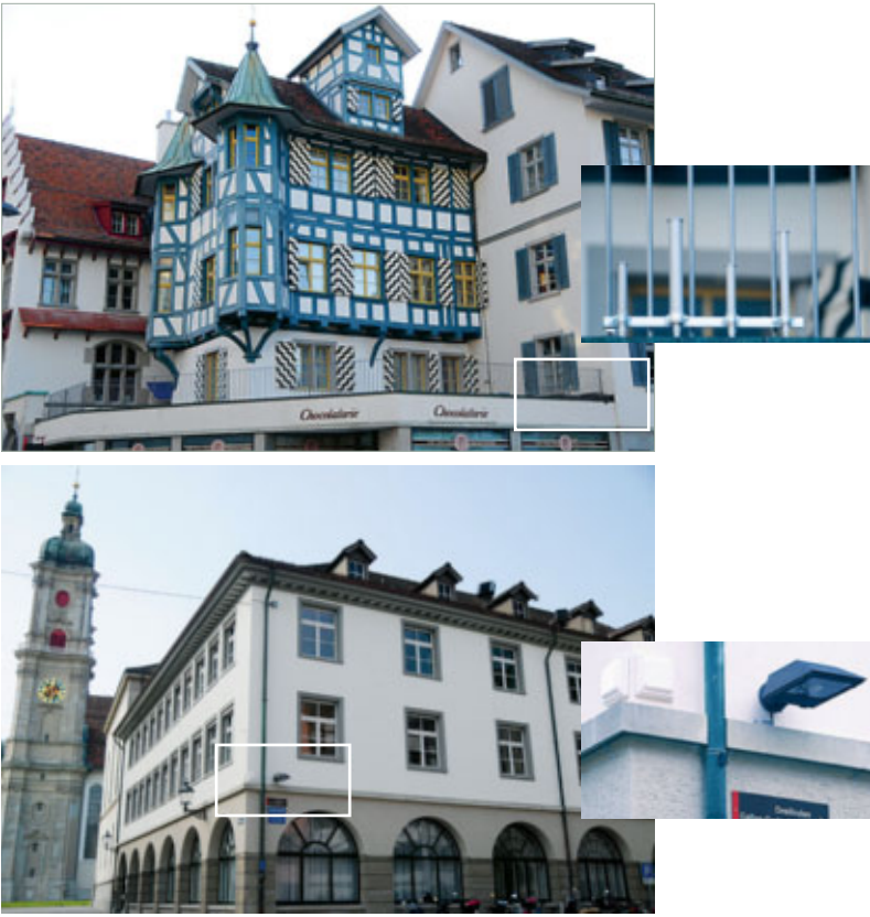
Unauffällige WLAN-Antennen versorgen einen Teil der St. Galler Innenstadt strahlungsarm mit drahtlosem Internet: Beispiele der Montage an einer Strassenlaterne, einem Metallgeländer und an einer Hausecke.
